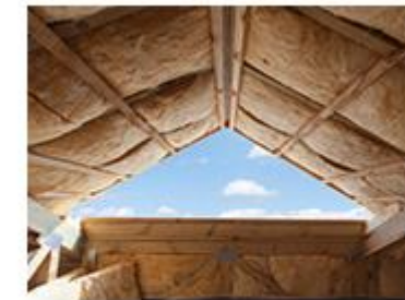
IZOLACIJA IN OKNA
